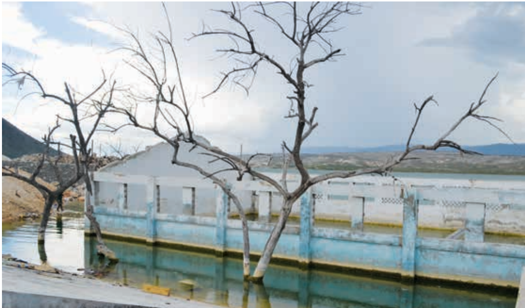
Bureau de douane inondé en raison de la montée des eaux d'un lac se situant à proximité, dans la frontière entre Haïti et la République dominicaine. © OIM 2014 (Photo : Susanne Melde)
