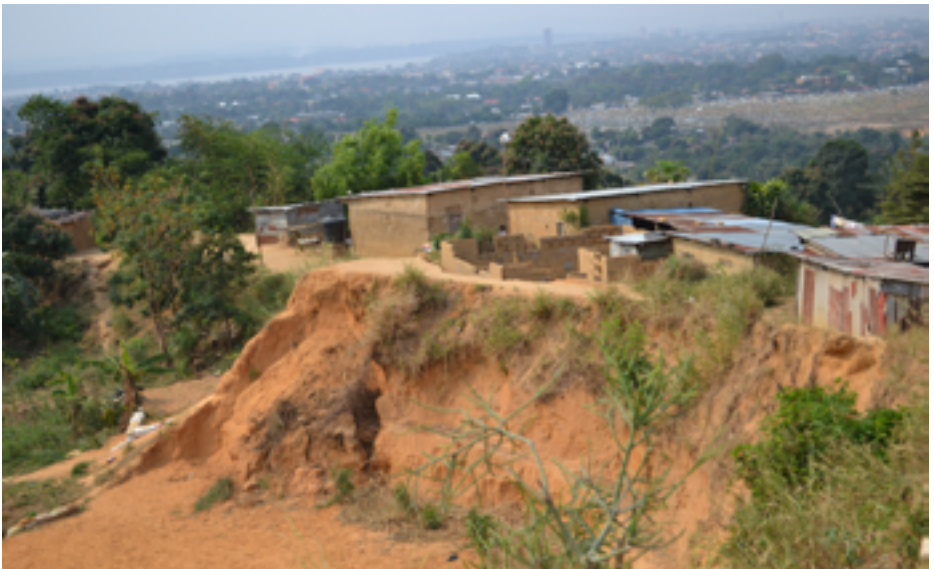
Figure 5 : Persistance de comportements à risque : la maison en construction n’est séparée du ravin que par la route
