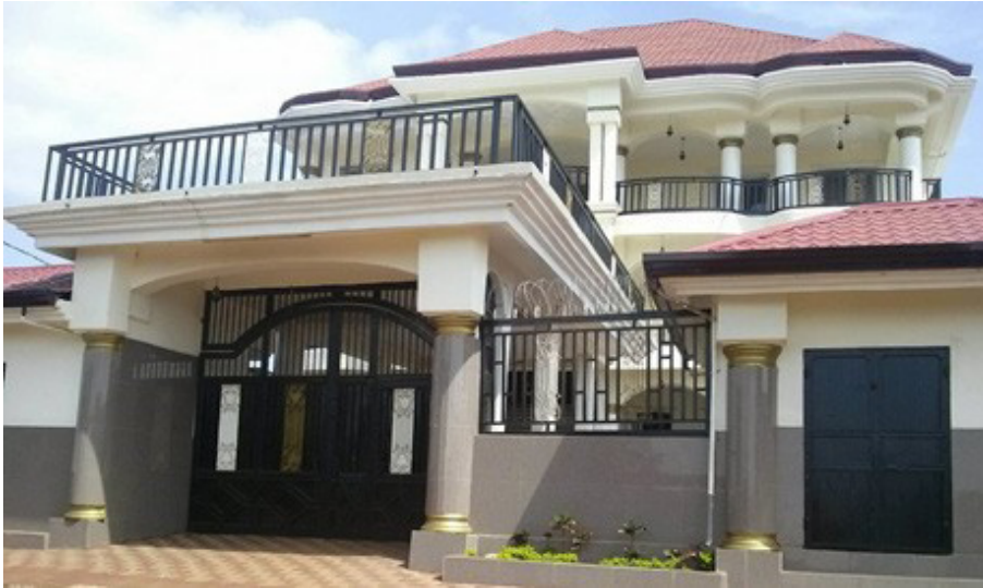
Maison construite par un Guinéen de la diaspora. © Altai Consulting, 2017.
