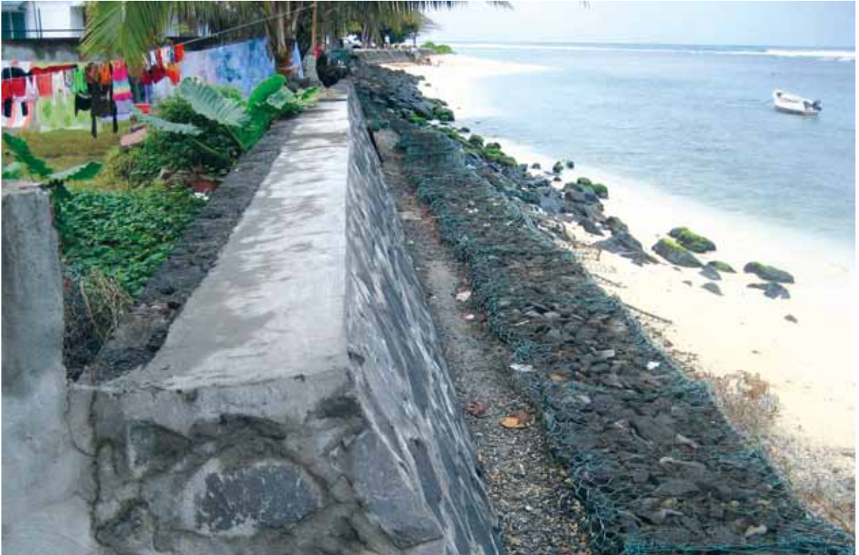
Protection wall and gabions in Rivière des Galets. © IOM, July 2010 (Photo: François Gemenne).
